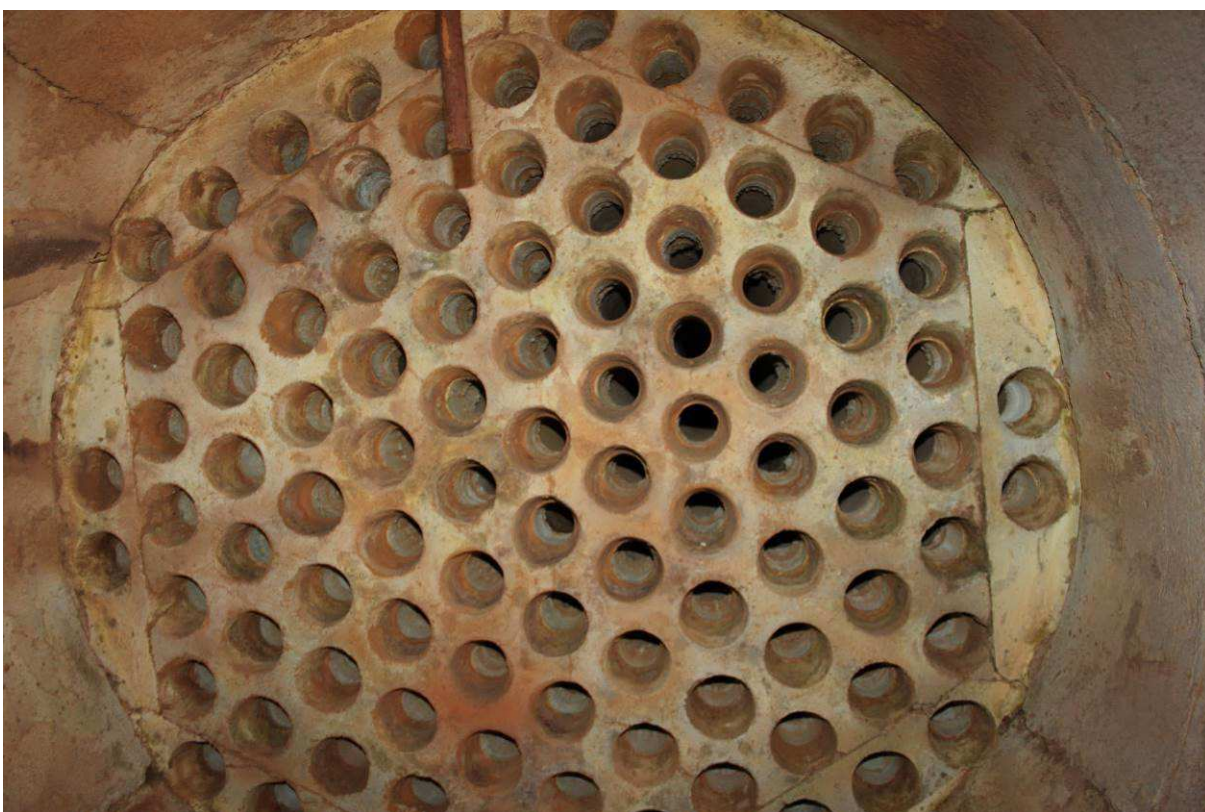
Foto 14 Vollständig nachgereinigter Austritts-Siebboden aus Beton vom 1. Zug des Abhitzekeessels. Das ist ein Zusatzeffekt der Wirkung der Stoßwelle.
