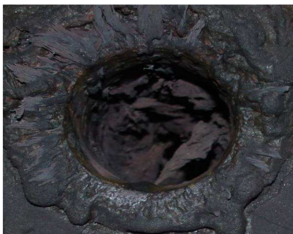
Foto 3 Verschmutzte Flammrohre im 1. Zug des Abhitzeessels.
