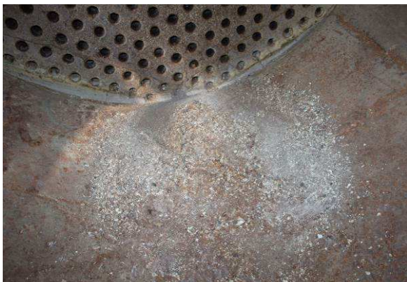
Foto 13 Geringe Menge von harten Ablagerungen am Boden der Zwischenkammer, die vom 1. Zug ausgeschieden werden.
