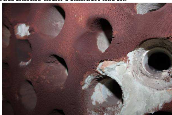
Foto 4 Dicke Schicht von losen Ablagerungen auf dem Siebboden am Auslauf des 1. Zuges.
