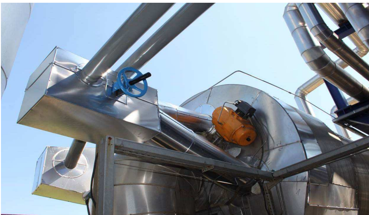
Foto 8 Eintrittsstelle der Stoßwelle auf die zu reinigende Flammrohre.
