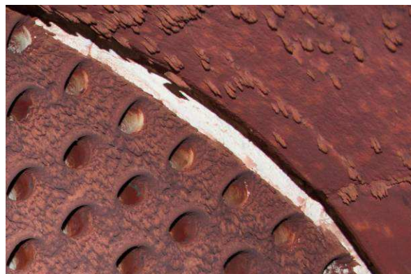
Foto 5 Mit Ablagerungen belegte Wände der Zwischenkammer die den 1. und 2. Zug des Abhitzeessels verbindet.
