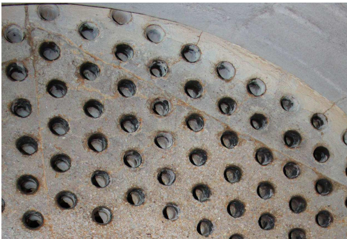
Foto 12 Oberer Teil des Siebbodens frei von jeglichen losen Ablagerungen.
