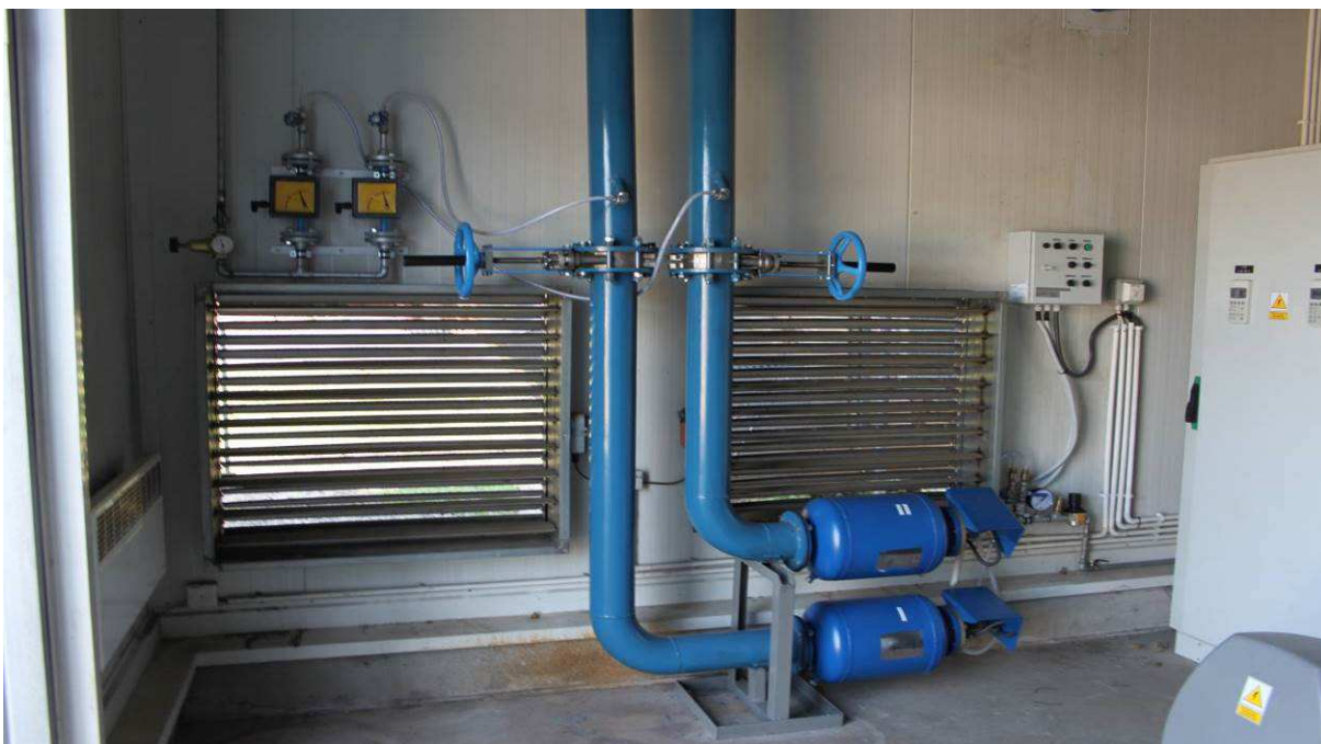
Foto 7 Zwei Stoßwellengeneratoren GFU-24/8 wurden im Elektrofiltergebäude eingebaut.
