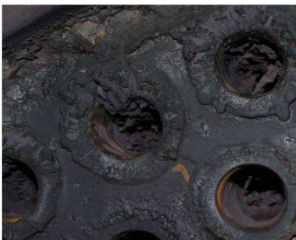
Foto 3 Verschmutzte Flammrohre im 1. Zug des Abhitzeessels.
