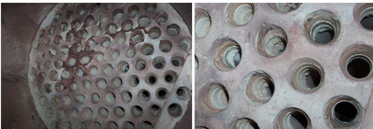
Fot. 11. Dodatkowy efekt czyszczenia za pomocą fali uderzeniowej. Wylotowe dno sitowe pierwszego biegu pozbawione osadów ograniczających przepływ spalin.
