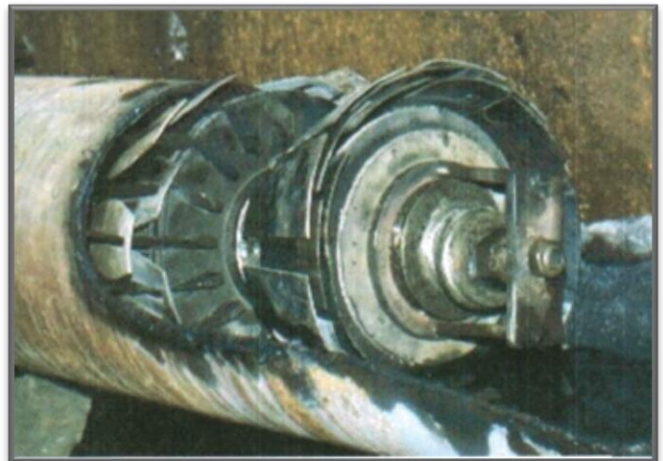
Wprowadzenie generatora do rurociągu
