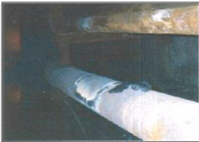
Zaślepienie otworu rewizyjnego oraz włączenie pomp tłocznych
