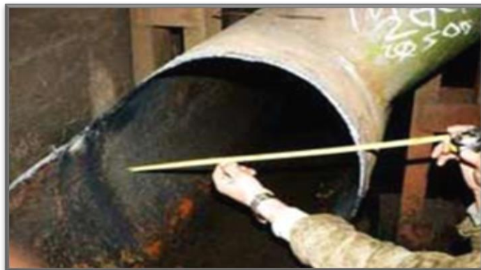
Rura po czyszczeniu za pomocą generatora kawitacyjnego
