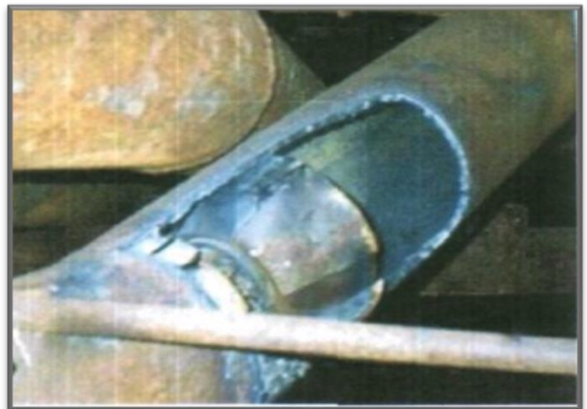
Wykonanie otworu rewizyjnego celem wyjęcia generatora
