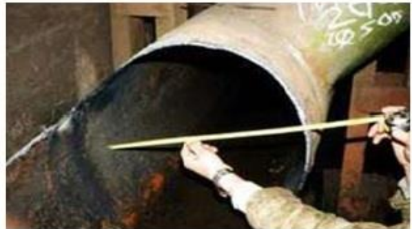
Przykład rury D 500 mm po czyszczeniu
