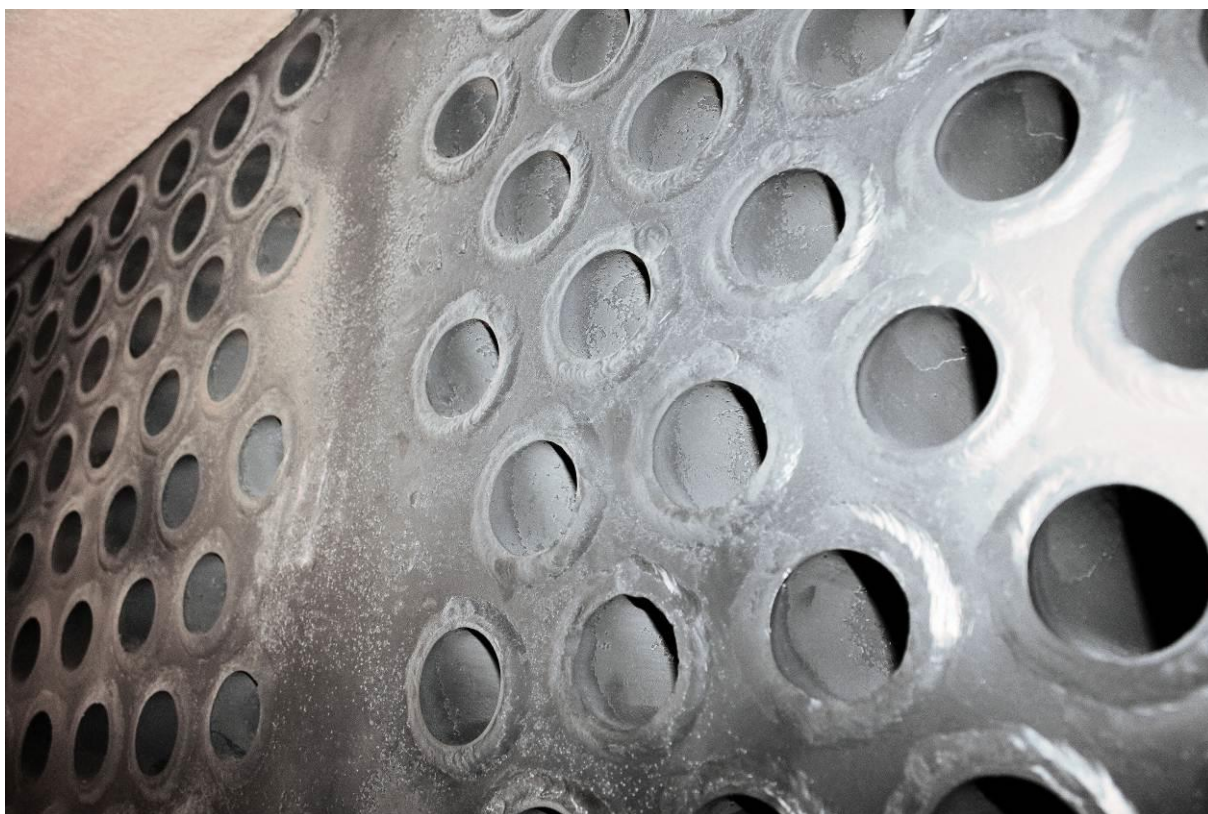
Fot. 16. Płomieniówki kotła nr 2 czyszczone generatorem GFU-24/8 w Zakładach Mleczarskich Sp. z o.o. w Łukowie.
