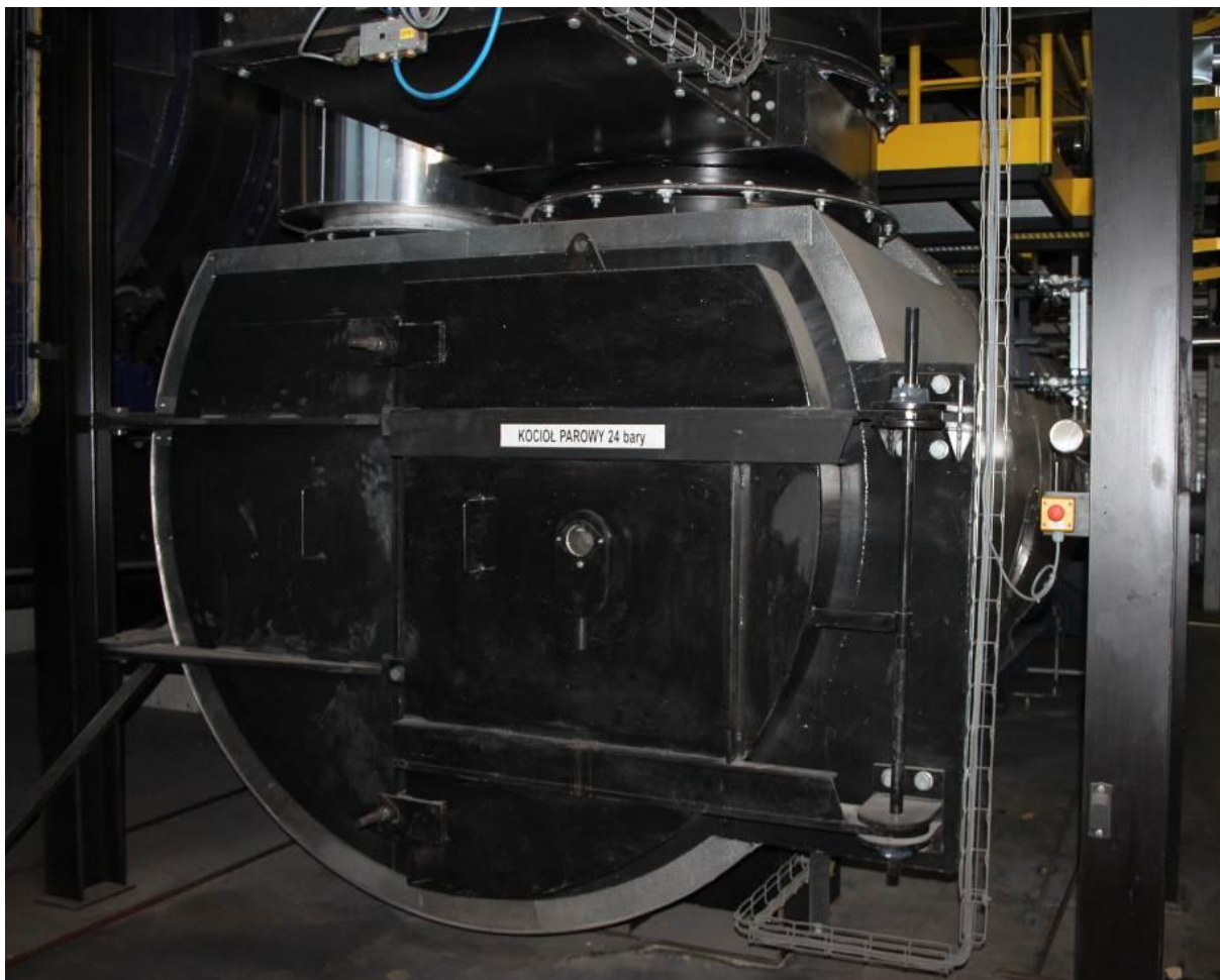
Fot. 1. Parowy wymiennik ciepła holenderskiej firmy HKB KELELBOUW.
