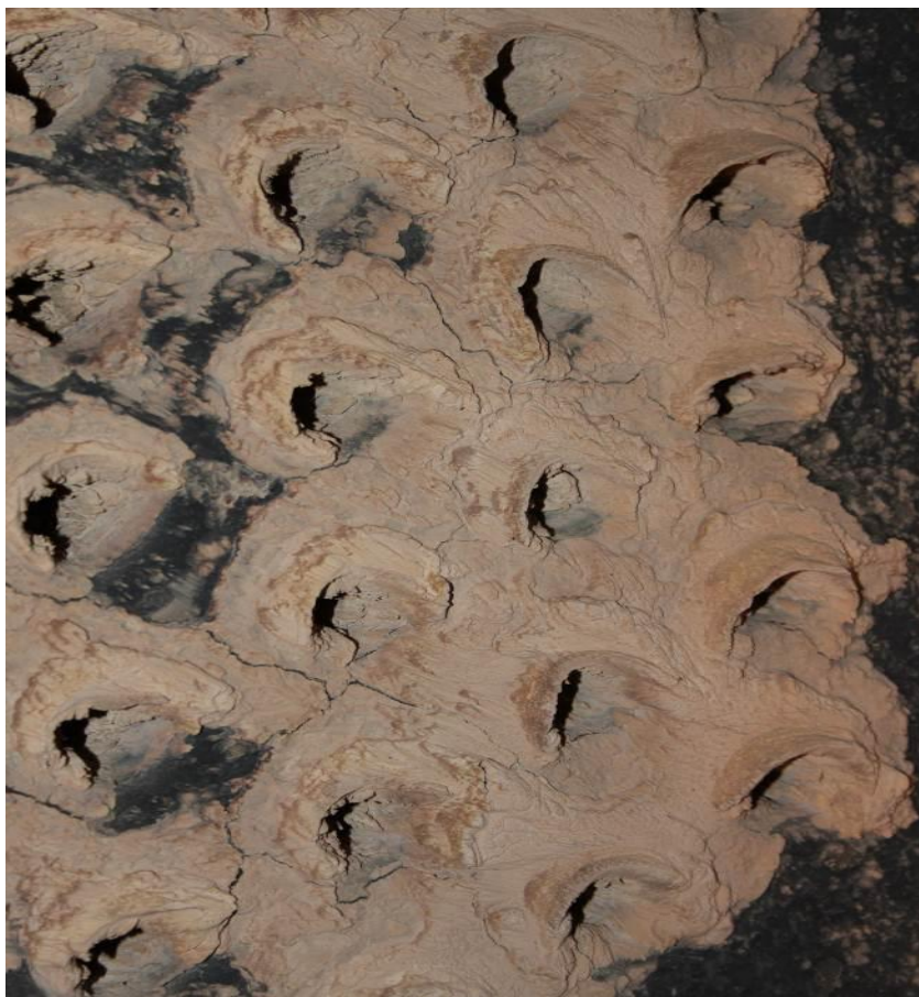
Fot. 2. Zalepione osadami płomieniówki.
