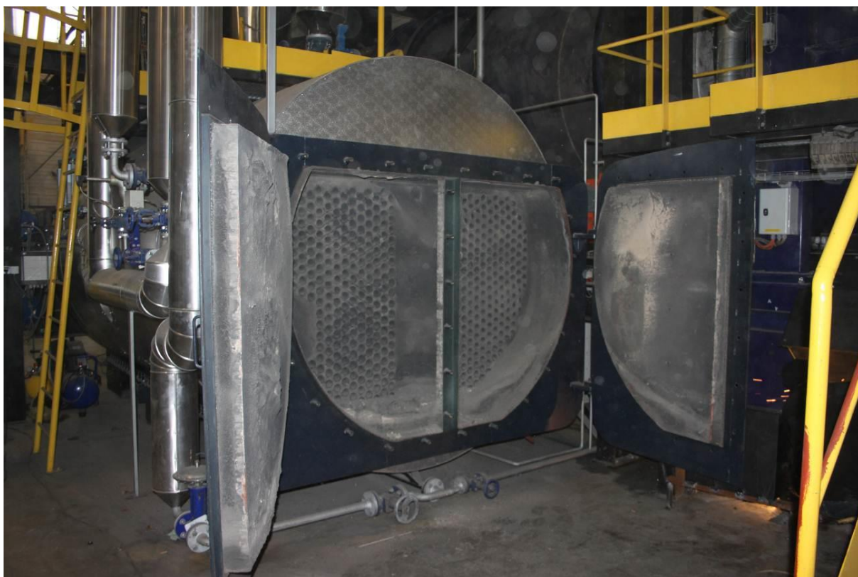
Fot. 10. Komora nawrotna wymiennika.
