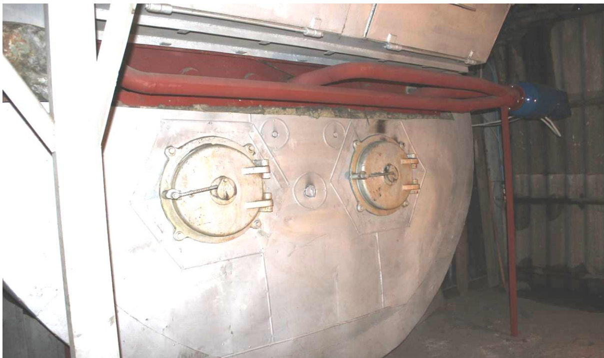
Fot. 18. Zabudowa generatora fal uderzeniowych na kotle płomieniówkowym.
