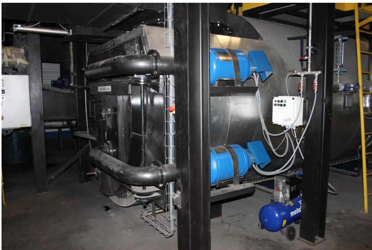
Fot. 4. Generatory fal uderzeniowych GFU-24/8.
