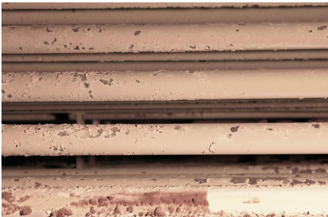
Fot. 10 Rury przegrzewacza pary kotła OR-32 wolne od osadów.
