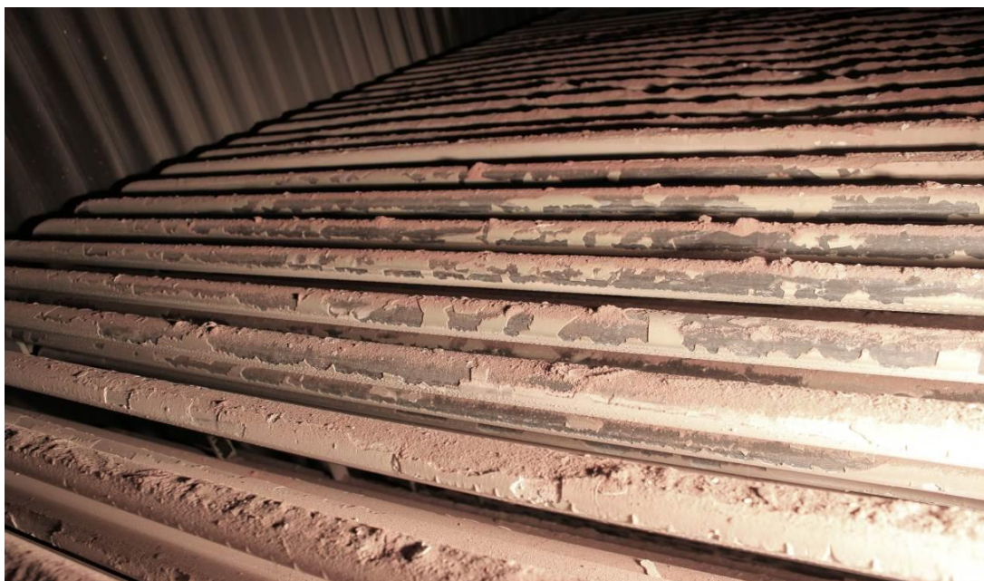
Fot. 14 Rury przegrzewacza pary pierwszego stopnia.
