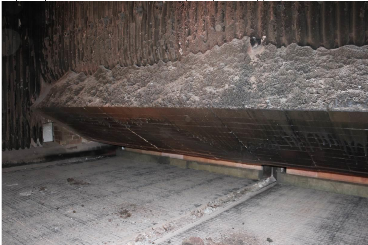
Fot. 3 Sklepienie zapłonowe.
