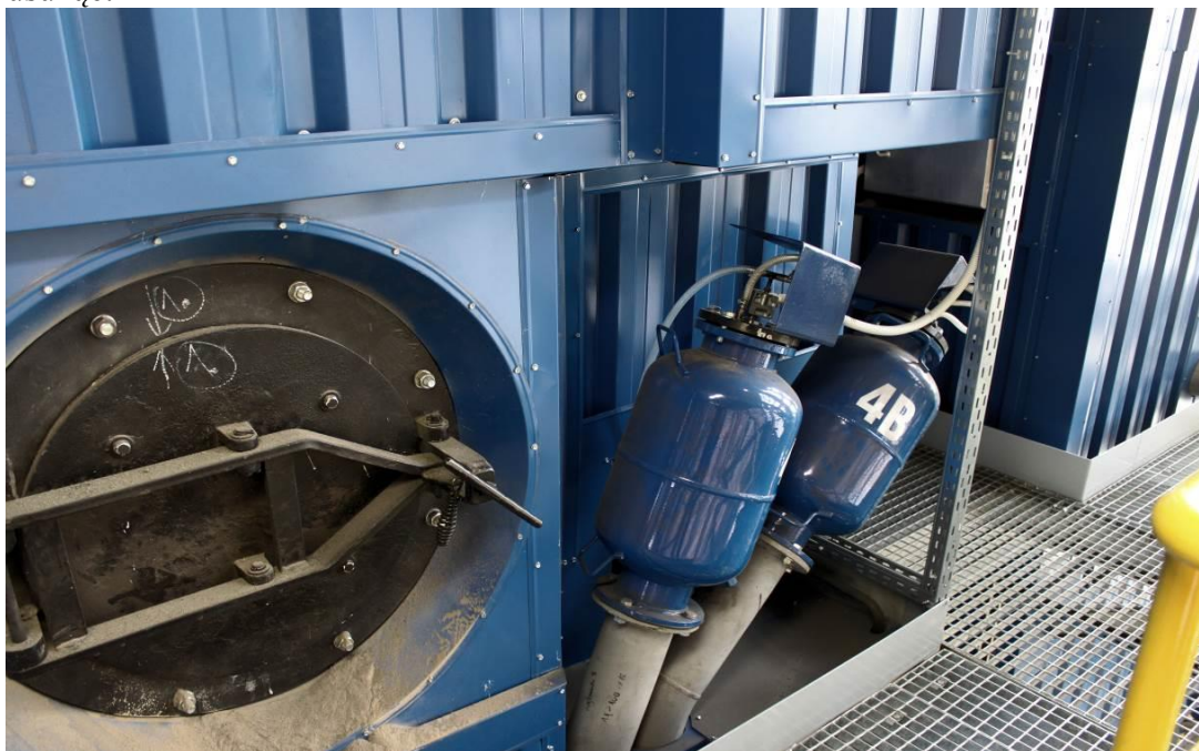
Fot. 13 Zabudowa generatorów w obrębie przegrzewacza pary pierwszego stopnia.
