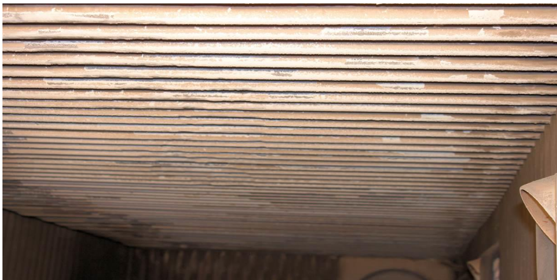
Fot.12 Rury przegrzewacz drugiego stopnia kotła OR-32.
