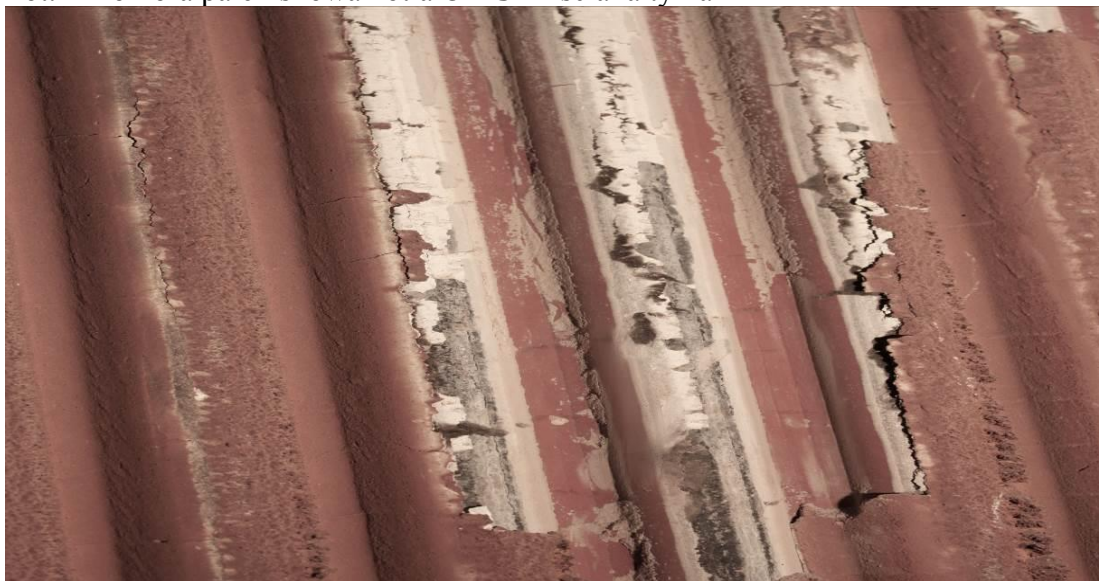
Fot. 2 Zabrudzenie rur komory paleniskowej.
