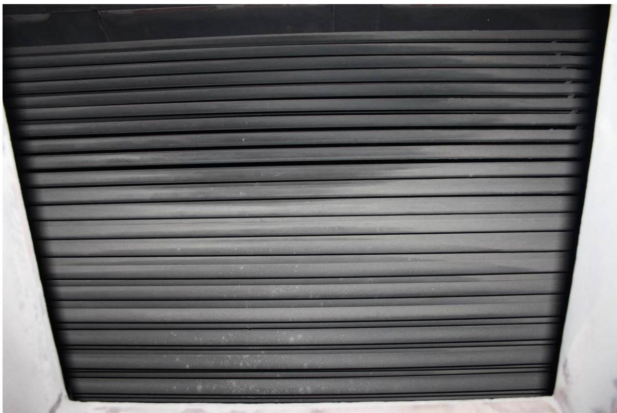
Fot. 7 Rury dodatkowego podgrzewacza wody ekonomizera.
