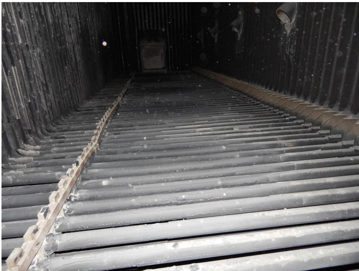
Fot. 5. Rury podgrzewacza wody bezpośrednio za festonem.
