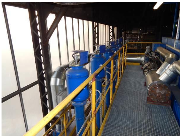
Fot. 2 Generatory GFU-24/8 czyszczące pierwszy pęczek podgrzewacza za festonem
