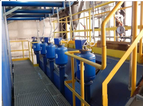
Fot. 3 Instalacja czyszczenia drugiego pęczka podgrzewacza wody w drugim ciągu.
