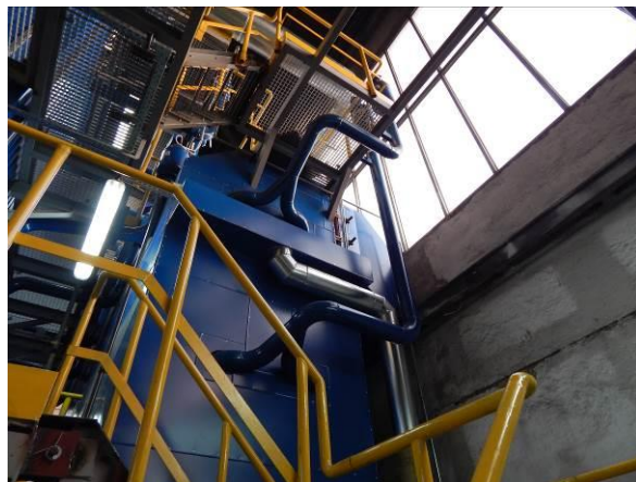
Fot. 4. Czyszczenie dodatkowego podgrzewacza wody
