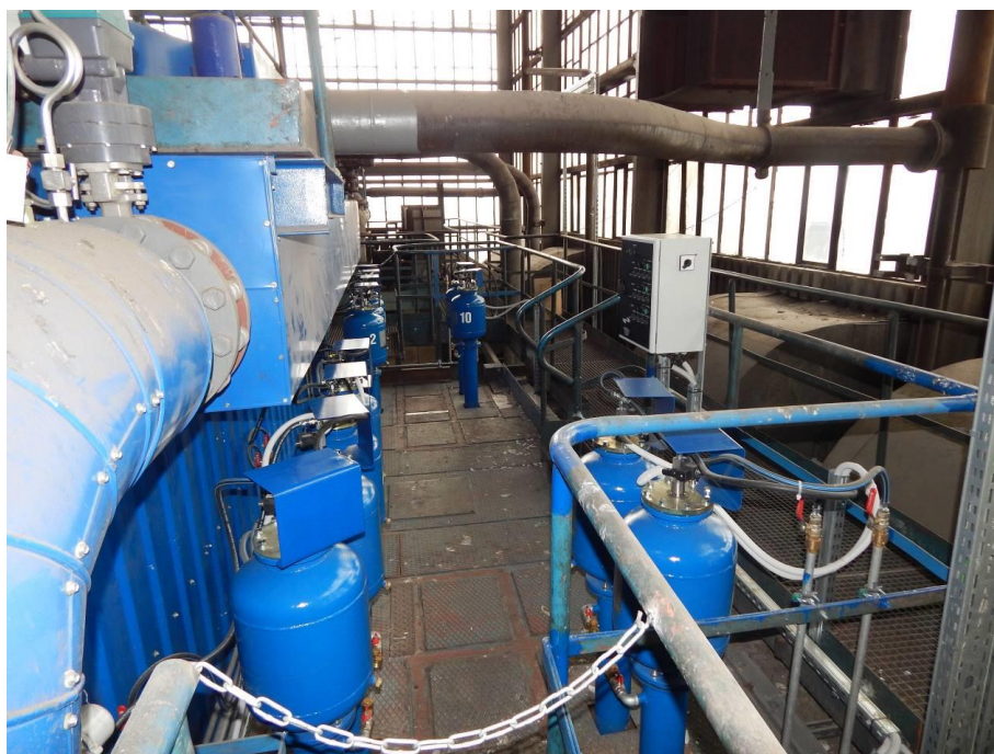
Fot. 4 System sterowania instalacji oczyszczania powierzchni konwekcyjnych.
