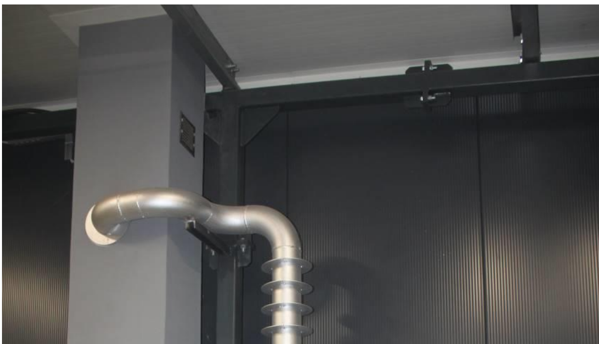
Fot. 3 Kratka wentylacyjna w górnej części przewodu kominowego.
