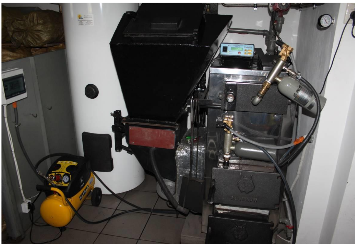
Fot. 6 System czyszczenia kotła o mocy 24 kW oparty o generator fal uderzeniowych GFU-1/15.
