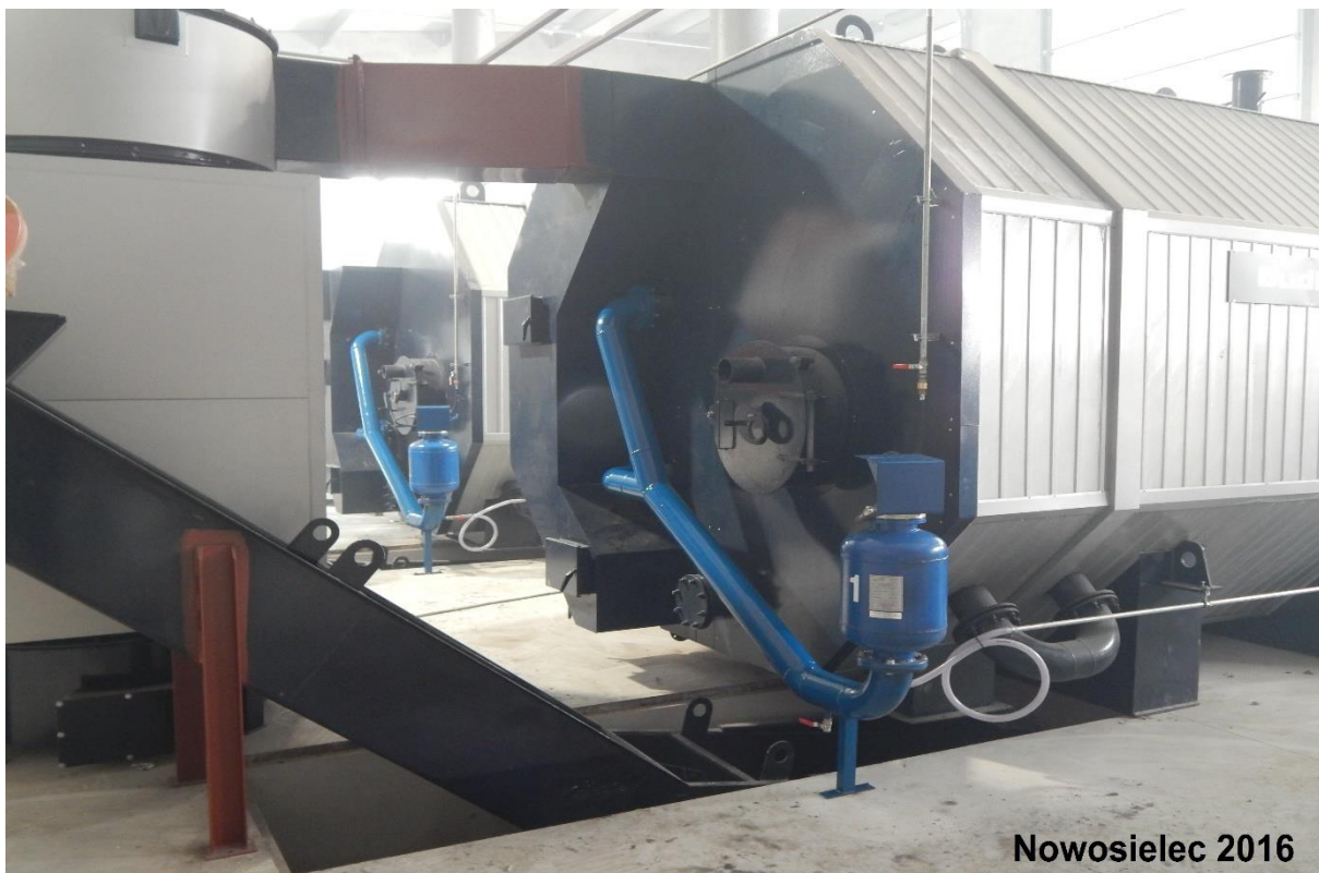
Fot. 6 System czyszczenia dwóch kotłów płomieniówkowych o mocy 3 MW.
