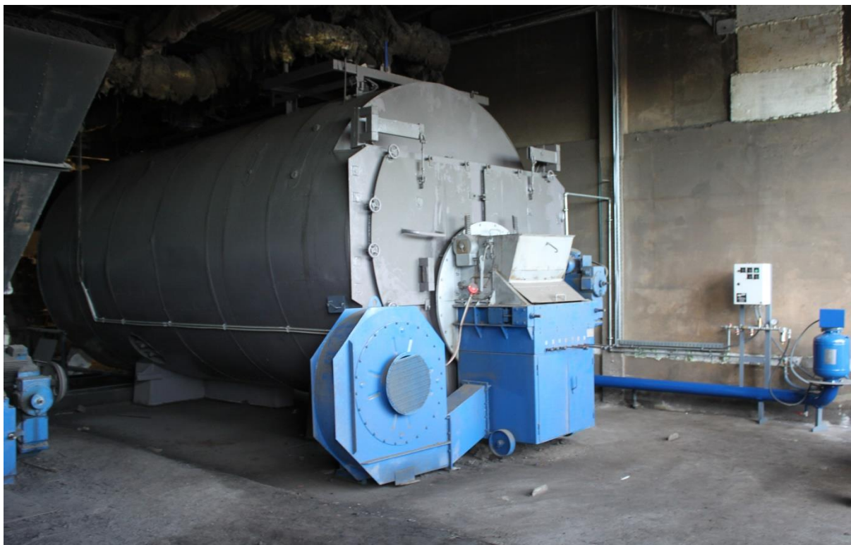
Fot. 3 Typowy kocioł płomienicowo-płomieniówkowy z rusztem ruchomym.
