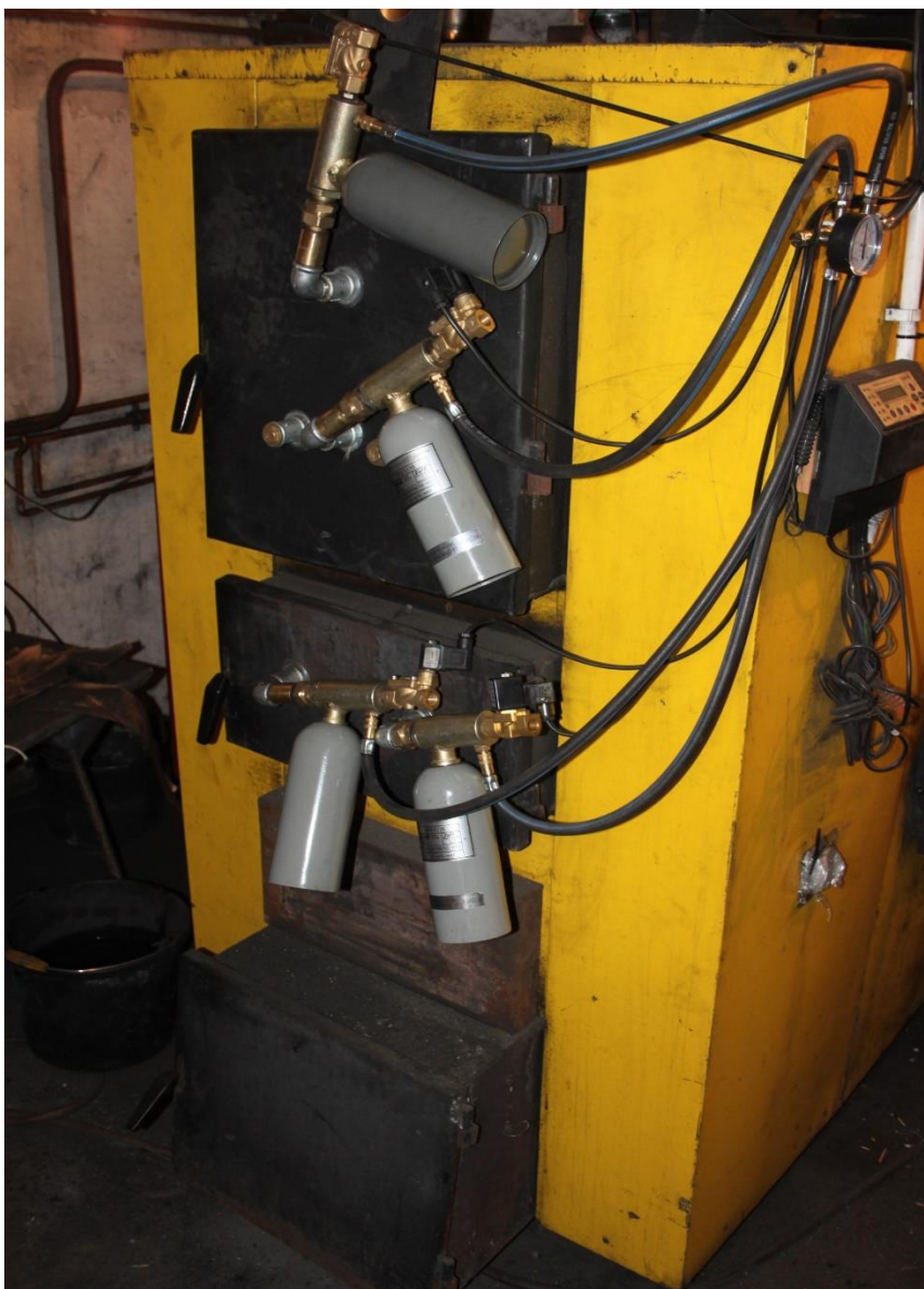
Fot. 5 System czyszczenia kotła o mocy 90 kW.
