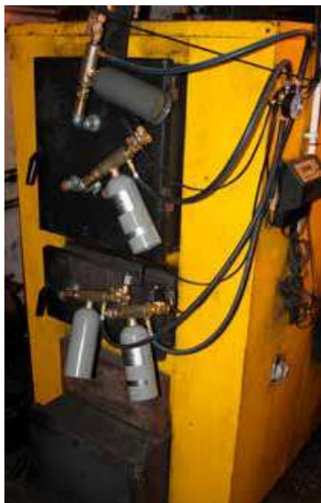
System czyszczenia kotła o mocy 90 kW
