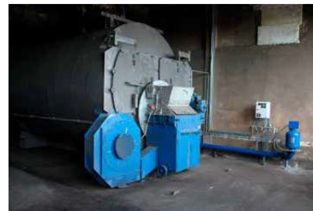
Typowy kocioł płomienicowo-płomieniówkowy z rusztem ruchomym
