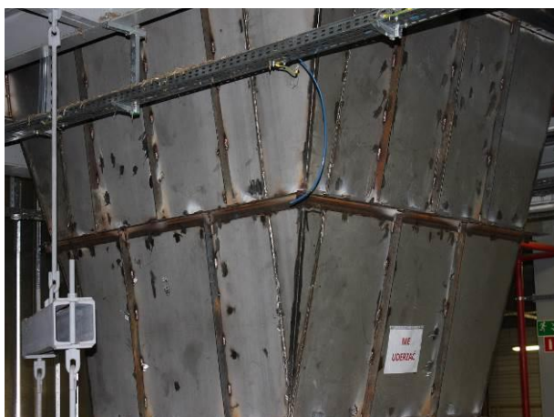
Fot. 10 Zasobnik słomy po modernizacji.
