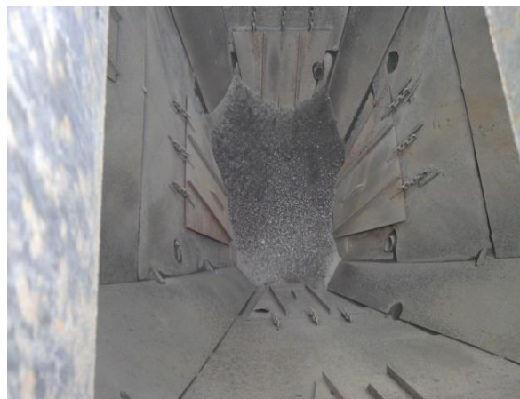
Fot. 5 Zasobnik rudy żelaza po uruchomieniu generatorów fal uderzeniowych.
