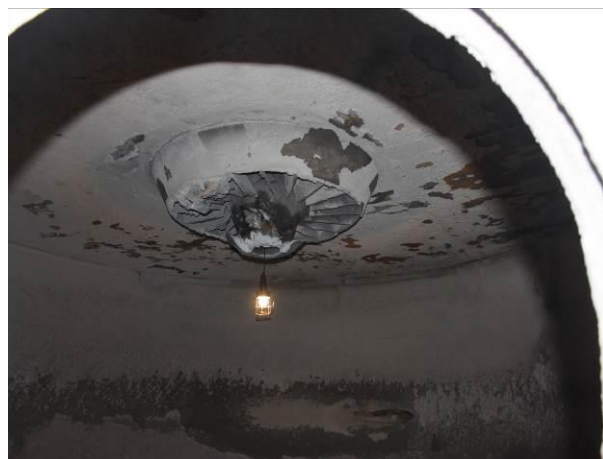
Fot. 15. Dysza wylotowa generatora fal uderzeniowych
