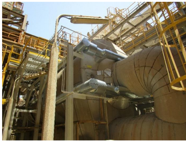
Instalacja czyszczenia kotła odzysknicowego (rurociągi pokryte blachą ocynkowaną) – TASNEE Arabia Saudyjska
