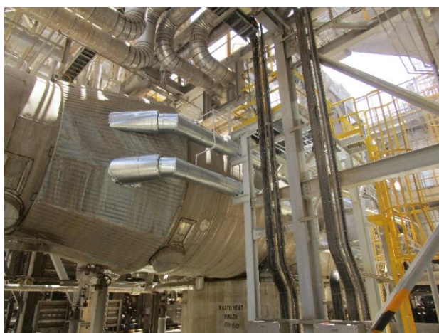
Instalacja czyszczenia kotła odzysknicowego (rurociągi pokryte blachą ocynkowaną) – TASNEE Arabia Saudyjska
