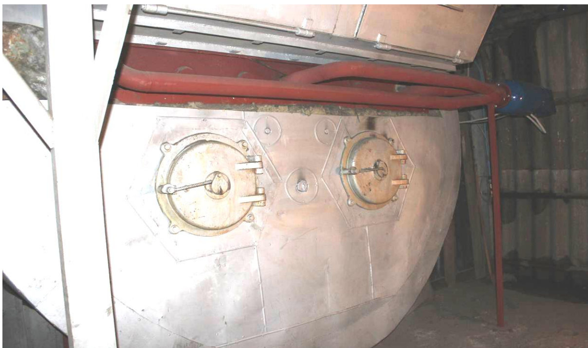
Fot. 8. Zabudowa generatora fal uderzeniowych na kotle płomieniówkowym
