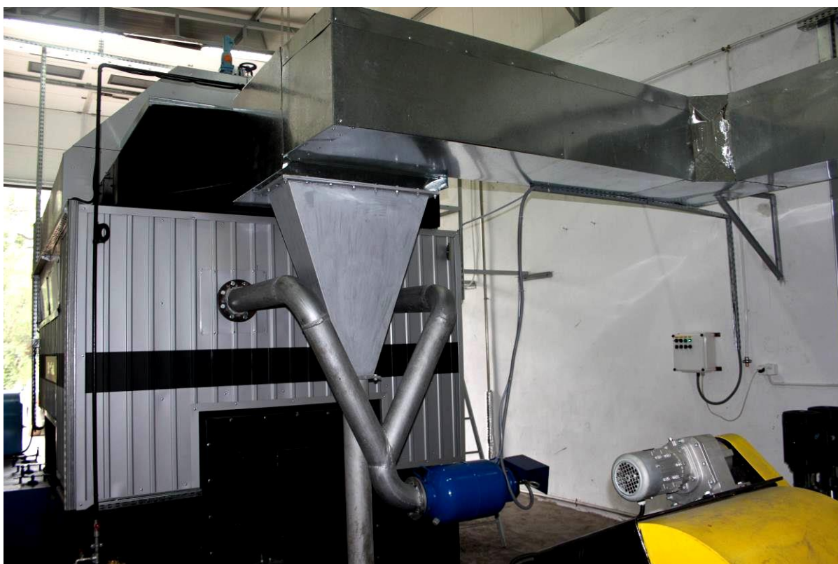
Fot. 2. Tył kotła płomieniówkowego wraz z generatorem fal uderzeniowych GFU-24/8.
