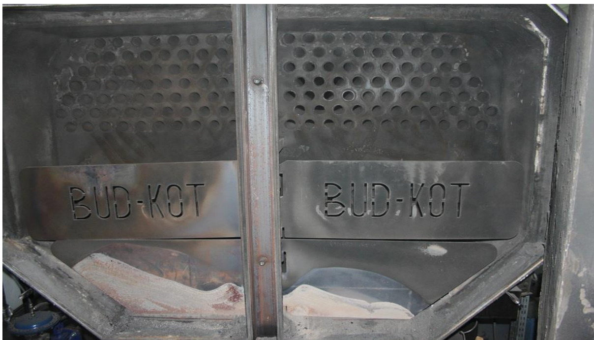
Fot. 1 Komora nawrotna kotła płomienicowego.
