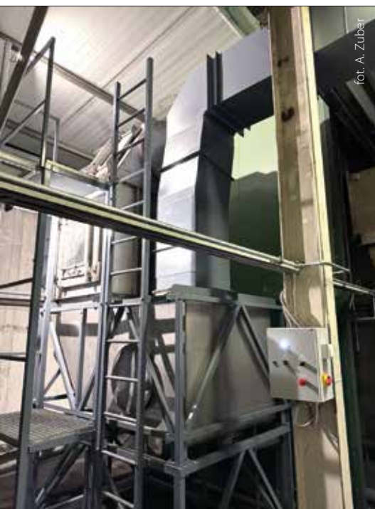
Filtr wodny do kotła płomieniówkowego o mocy 5 MW
