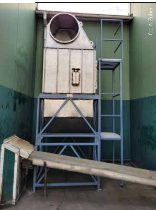
Przedmontaż filtra wodnego do kotła o mocy 5 MW
