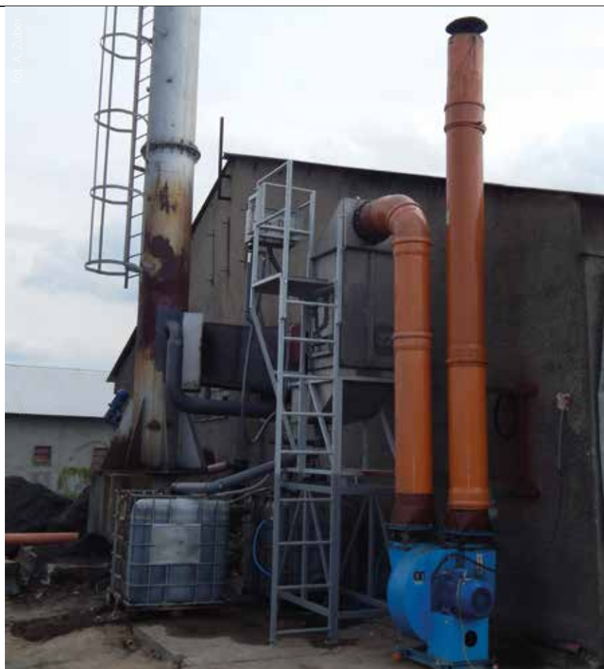
Filtr wodny za kotłem opalanym słomą – instalacja testowa
