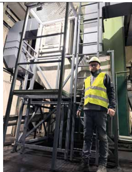
Filtr wodny z kanałami spalin dla kotła o mocy 5 MW
