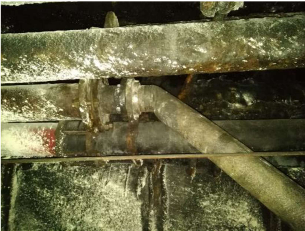
Fot. 4. Połączenie węża hydrantowego do rurociągu
