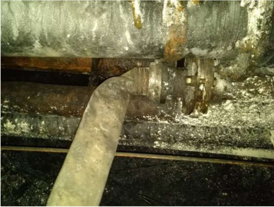
Fot. 4. Połączenie węża hydrantowego do rurociągu
