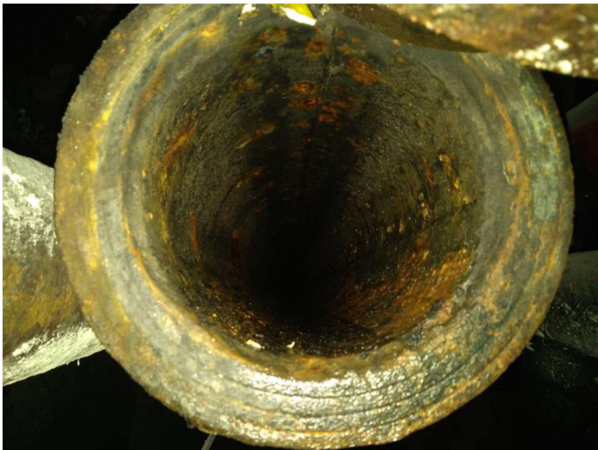
Fot.7. Oczyszczony rurociąg technologiczny
