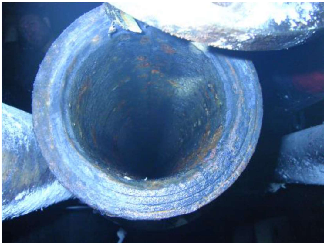
Fot.7. Oczyszczony rurociąg technologiczny
