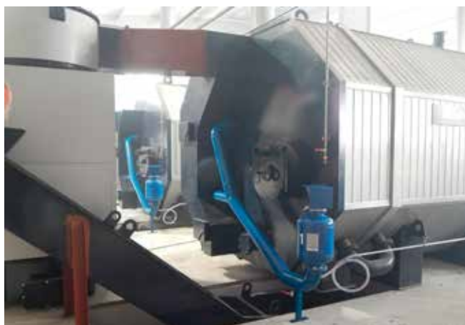
Fot. 3. System czyszczenia płomieniówek kotła biomasowego o mocy 2 MW
