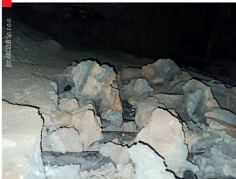
FOT. 1 Osady w kotle WR-10 po kilku dniach spalania pelletu
